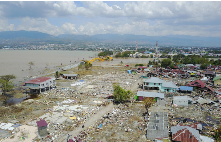
Gambar 5.10 | Likuefaksi di Palu, Sulawesi Tengah
